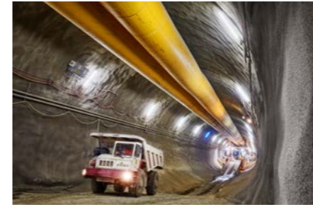
Gubristtunnel Zürich Tunnel de Gubrist
